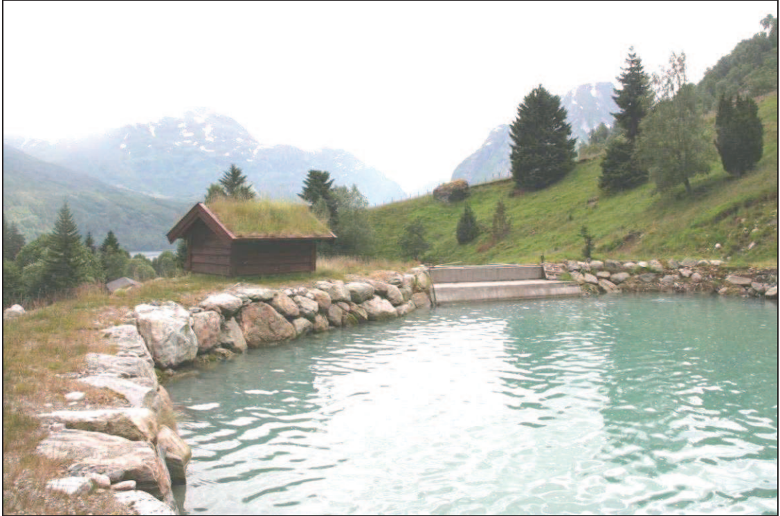
Figur 5. Kraftstasjonen er planlagt på ryggen i bakgrunnen, kote 200, mens avløpsvannet blir ført tilbake til eksisterende inntaksdam til Neselva I kraftverk i forgrunnen, kote 195, via en nedgravd betongkulvert med diameter 1,2 m (foto 13. juli 2008: Ole Kristian Spikkeland).
