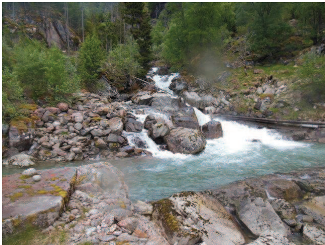
Medel sommarvassføring 3,5 m 3 /s ved kraftstasjonen
