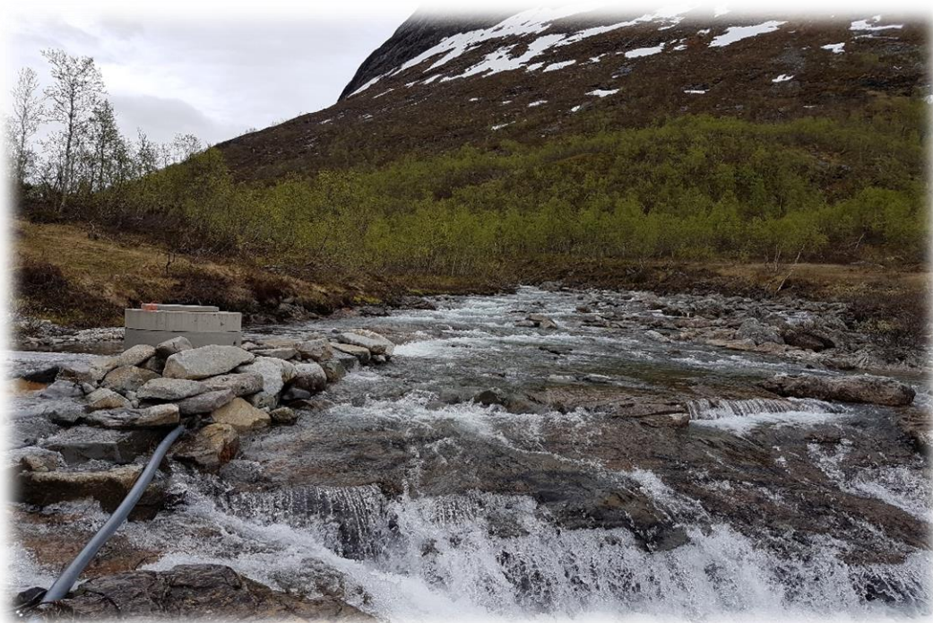
Bilde 3 Inntaksområde sett nedenfra
