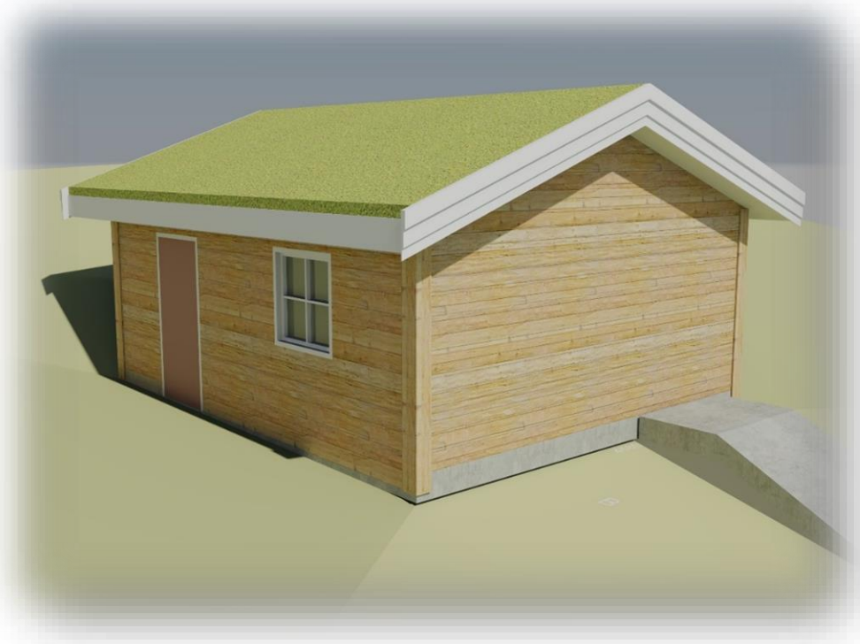
Bilde 8. Eksempel på kraftstasjon
