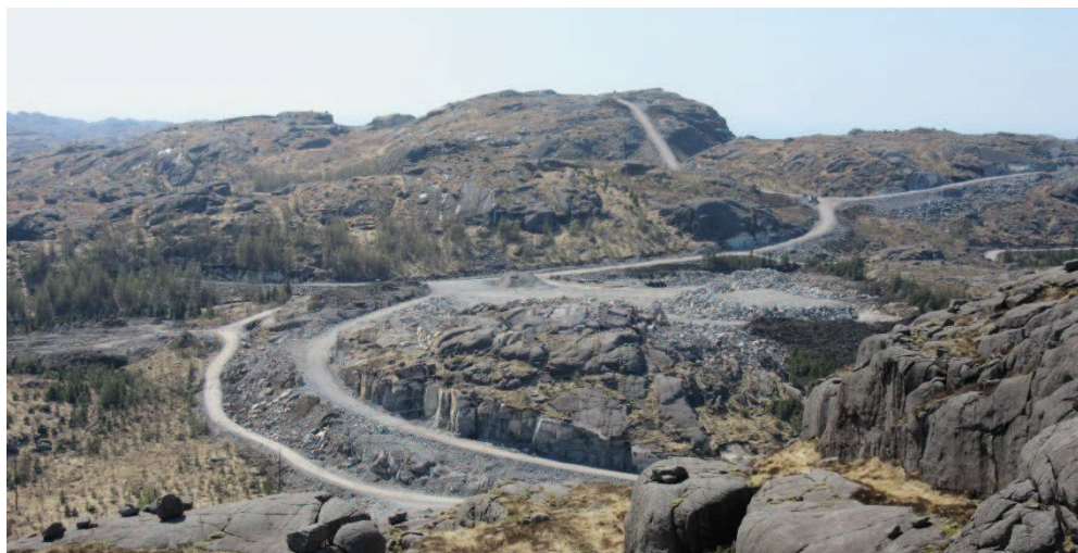
Figur 1 1: Anleggsfase i Bjerkreim vindkraftverk. Foto: SveinulfVågane.
