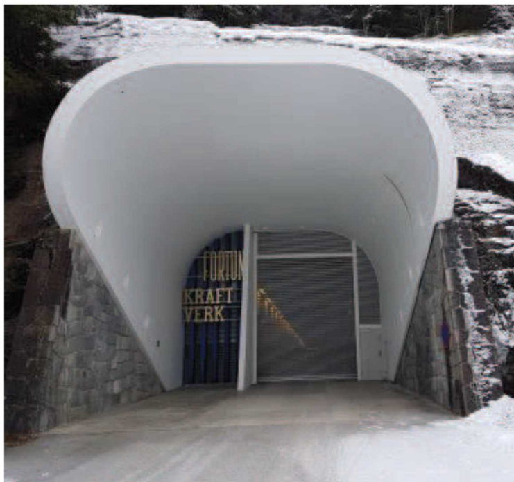
Figur 4 Inngang Skagen kraftverk
