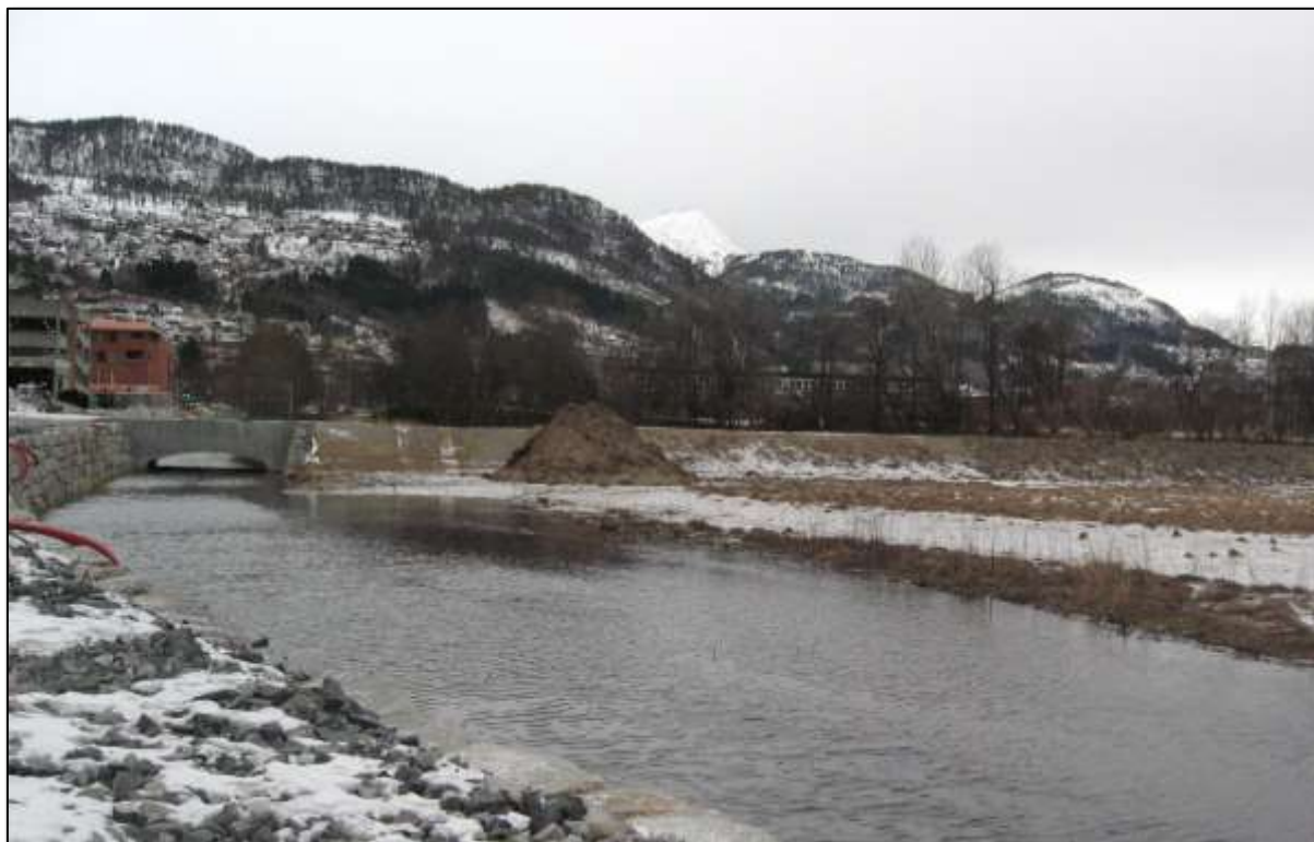
Figur 6-15: Gangbru/kulvert som nyleg er etablert i samband med legging av fjernvarmerøyr. Foto: Førde kommune.
