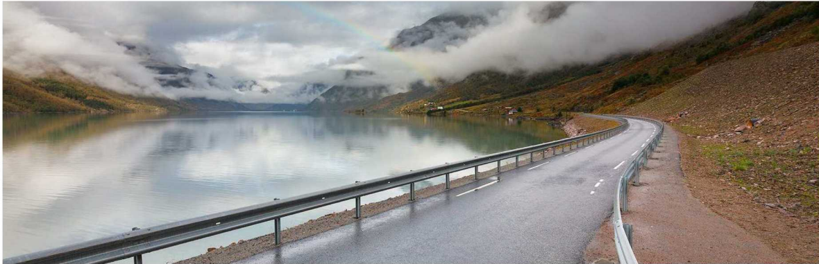
Nye tiltak for rassikring på vegen til Veitastrand. Foto: Stian Nest
