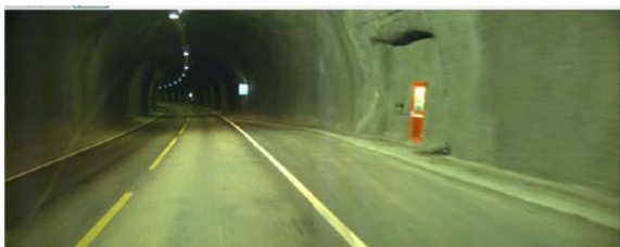
Havarilomme Gullringtunnelen fv. 55
