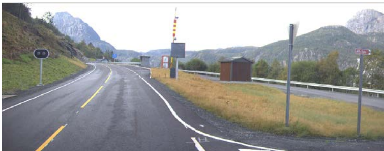
Utstyr til stenging av tunnelen Nishammartunnelen fv. 57
