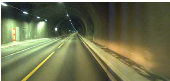
Nødfortau Bortnetunnelen fv. 616
