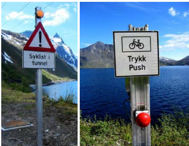
Eksempel på signalvarslingsystem for syklist i tunnel
