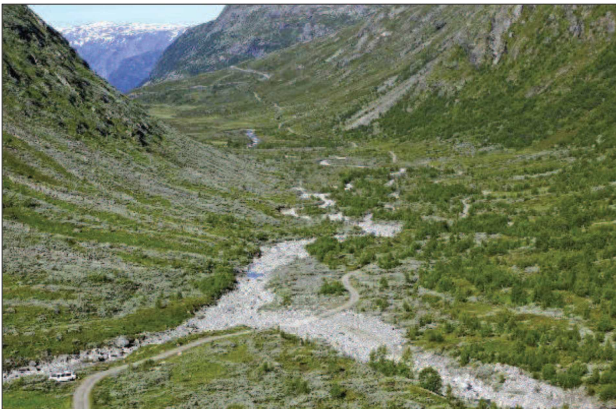
Figur 6-1. Tørrlagte elvestrekninger like nedstrøms inntakene i Helgedalen og Steindalen.
