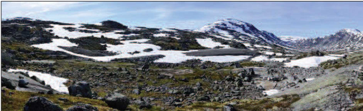
Figur 6-6. Massedeponiet øverst i Middalen fremstår som et noe fremmed objekt med sin ensarta, slette overflate. Overflaten burde bestå av grøvre fragment, sammen med noen større blokker som ville stått for brudd i arealet ville deponiet blitt mindre fremtredende i landskapsbildet.
