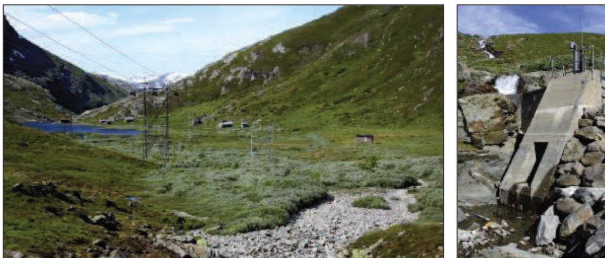
Figur 3-11. Et mer sammensatt landskapsbilde med vann og støl i den øvre delen av Berdalen, med et visst utsyn mot fjellrekken bakenfor. Inntakene, som vist fra Tverrelva er godt intergrert i landskapet, med betong inn mot eksisterende berg og plastring av stein.
