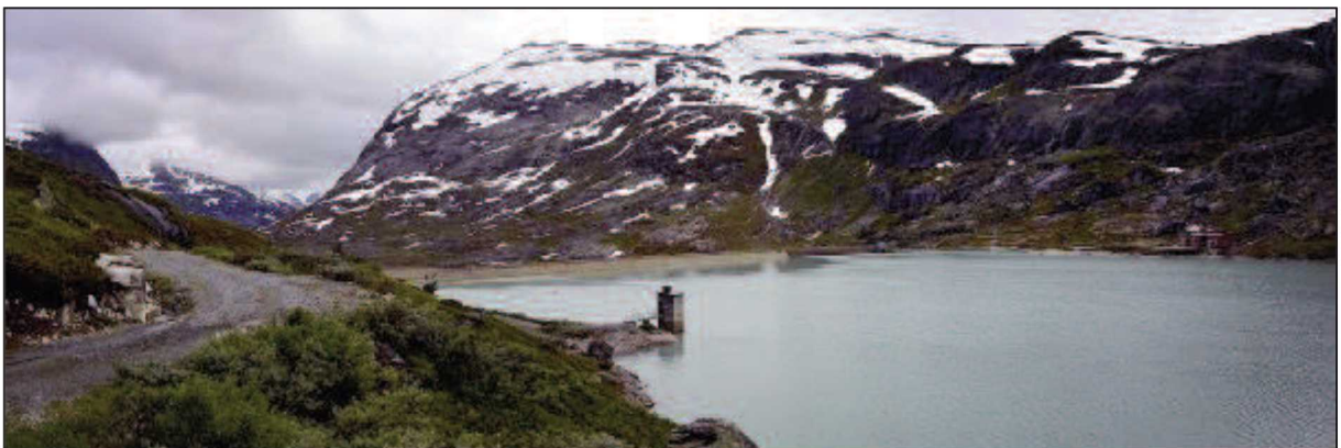
Figur 3-36. Dam med reguleringsmagasin og tilhørende konstruksjoner utgjør store inngrep i landskapsbildet ved Fivlemyrane, men oppleves som moderate oppstrøms, der det store vannspeilet dominerer i landskapsbildet.
