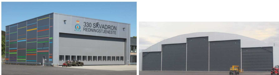
Stålbygg: flyhangar for Norwegian og helikopterhangar for 330 skvadronen ved Florø lufthavn som er kledd med Paroc elementer.
