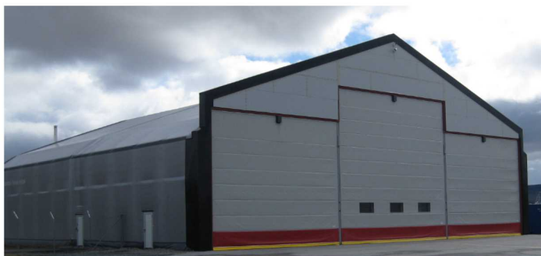
Widerøe hangar av typen isolert plasthall ved Røros lufthavn 30x30 meter
