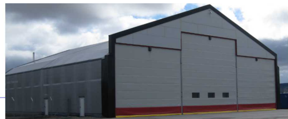
Isolert plasthall på Røros lufthavn
