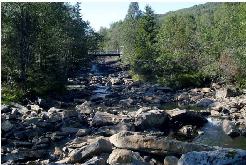
Inntaksområdet. 21. juli 2014. Låg vassføring ca. 0,3 m 3 .
