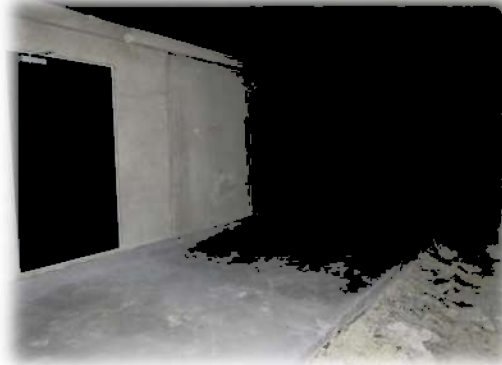
Teknisk bygg, tunnel
