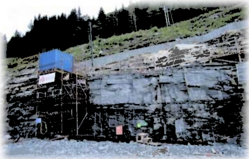
Betongmurar topp skjering ved Uгла
