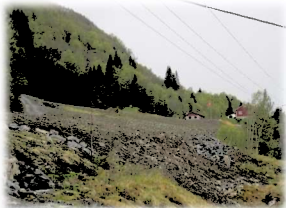
Ferdig planert deponi
