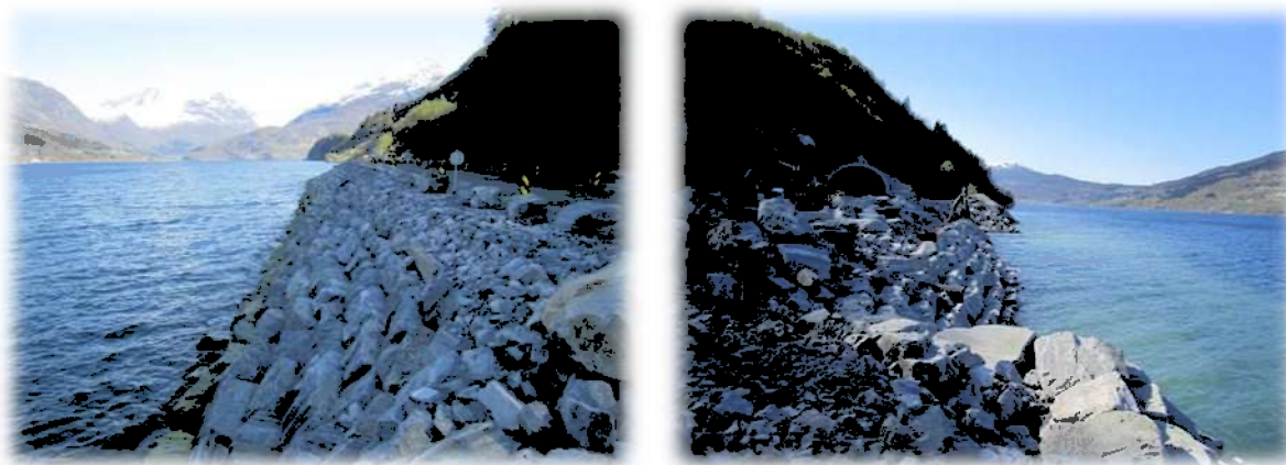
Plastring mot sjø
