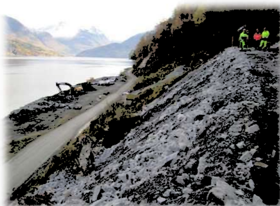
Topp forskjering i aust mot sjøfylling
