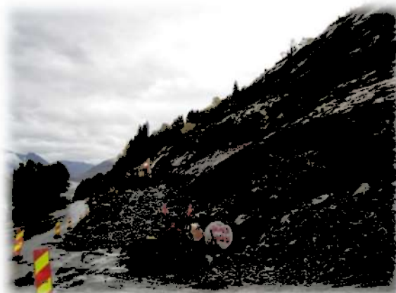
Omfattande sikringsarbeid på Ugla
