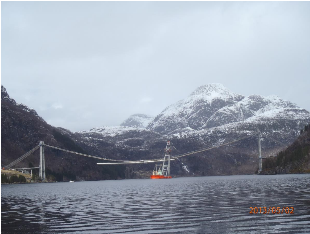
Foto frå montering av bruelementa.
