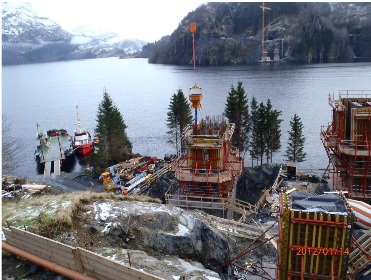
Forskaling av fundament og tårn, sett frå Otterstein mot Nishammar.
