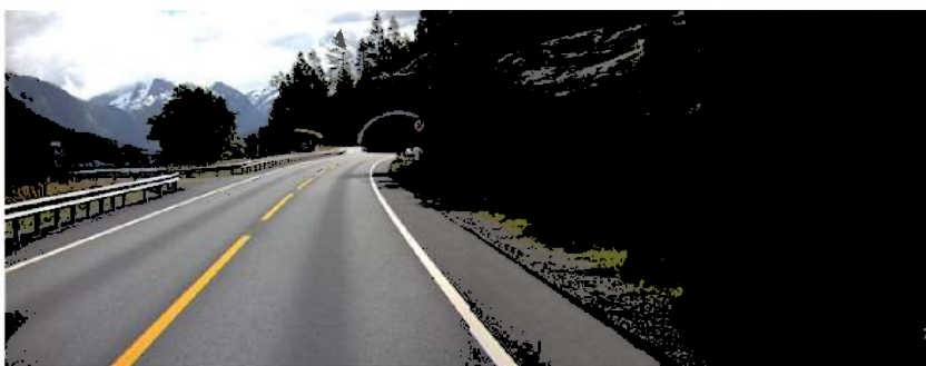
Figur 4 Ved Agjeldstunnelen vest
