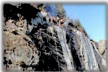
Det vart mykje ekstra sikring i fjellskjering.
