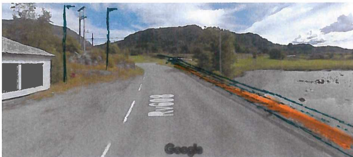
Veg sett frå straumsbrua mot kryss Fv 361:
