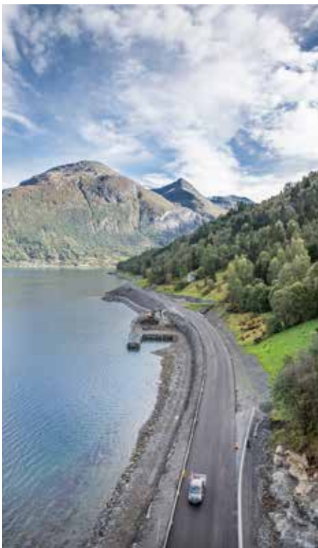
Heile fv. 60 mellom Olden og Innvik stod ferdig i 2018. Den siste strekninga med ny veg, mellom Ugla og Skarstein, vart opna i mars. Foto: Silje Drevdal/Statens vegvesen
