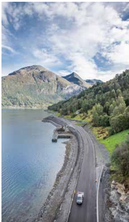
Heile fv. 60 mellom Olden og Innvik stod ferdig i 2018. Den siste strekninga med ny veg, mellom Ugla og Skarstein, vart opna i mars. Foto: Silje Drevdal/Statens vegvesen
