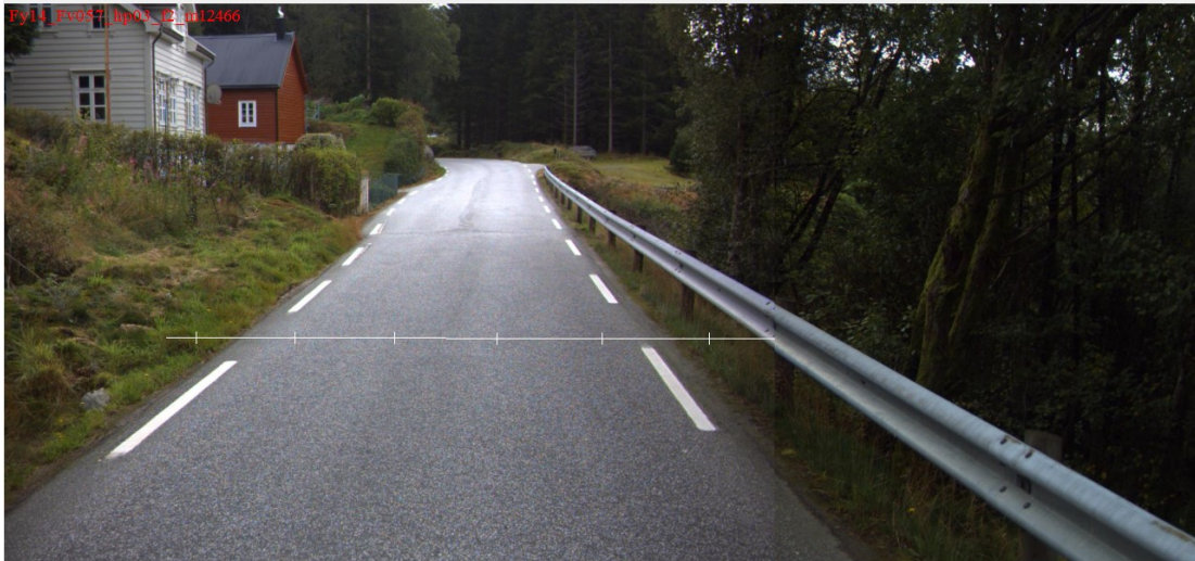
Fylkesveg 57 før bygging:
