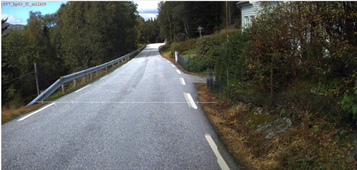
Fylkesveg 57 før bygging:
