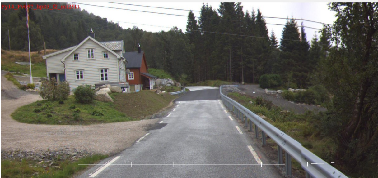
Fv. 57 etter bygging:
