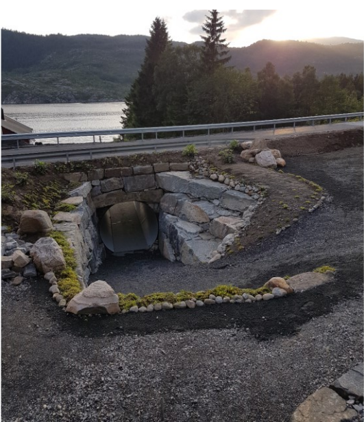
Kulvert under fylkesveg 57:
