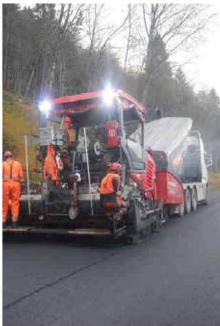
Rykande fersk asfalt vert lagt på fv. 60 Ugla-Skarstein. Veganlegget er planlagt opna for trafikk 1. mars 2018. Foto Statens vegvesen.
