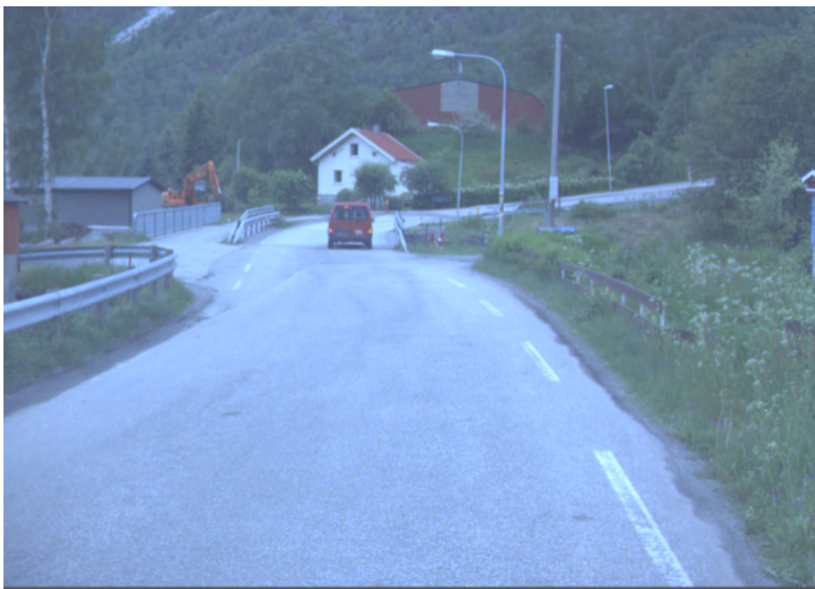
Vegbilde - Statens vegvesen: Over brua ved Årebru er det separat gang- og sykkelveg bak rekkverk, og vidare langs vegen i Seimsdalen er det ei strekning med fortau.
