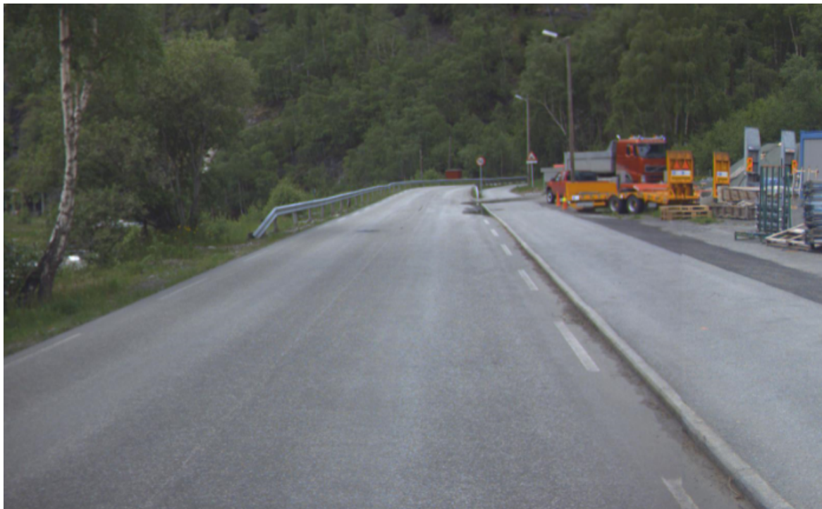
Vegbilde - Statens vegvesen: Fortau langs vegen mot Seimsdalstunnelen.
