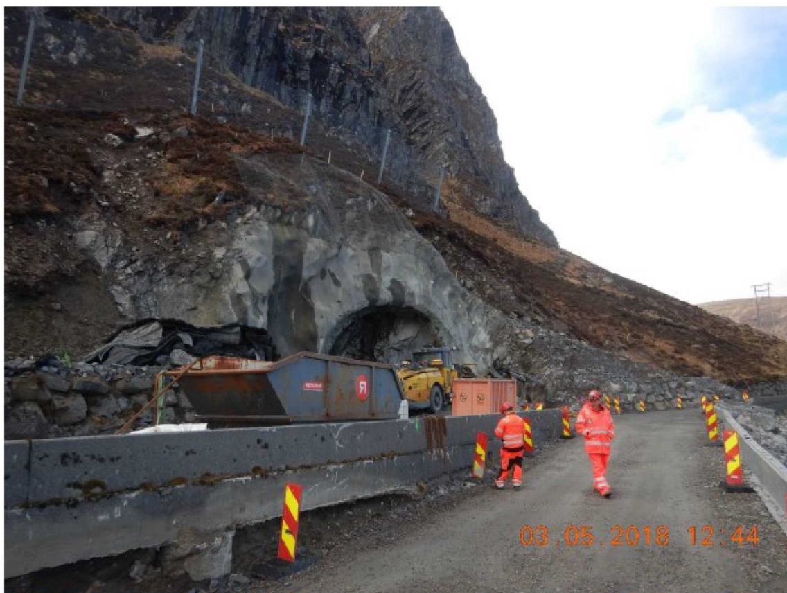
Figur 3 - Påhogg Gatteneset. Merk fanggerde og steinsprangnett over påhogget. Foto: Gro Kjoss Lyng, SVV
