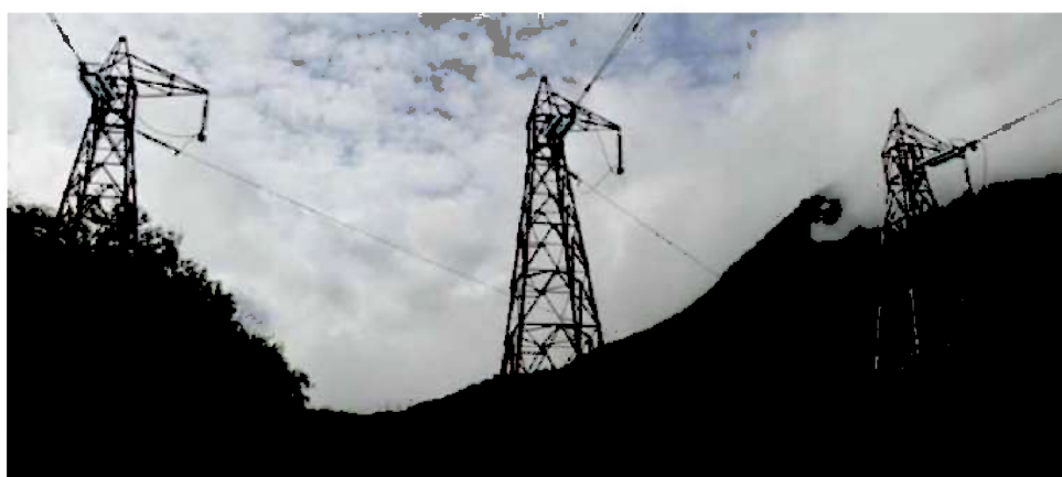
Figur 2.4. Eksempel på 132 kV fjordspennmuster.
