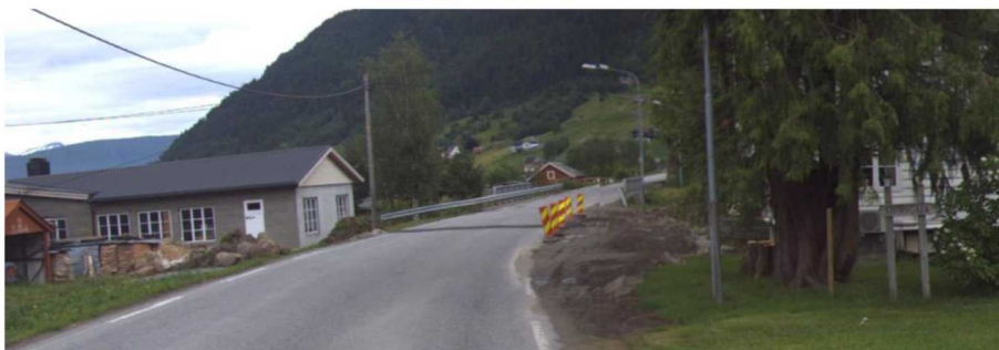
Fig. 12 Vegsituasjonen sett frå vest
