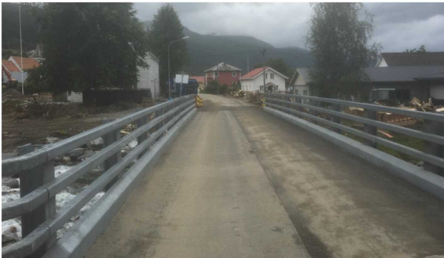
Fig 5 Mellombelsbru den 31.07.2017 Foto: Statens vegvesen
