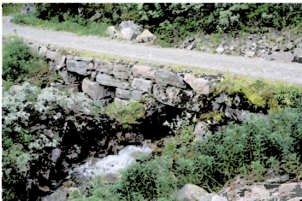
Tv: Rehabiliterert stikkrenne
