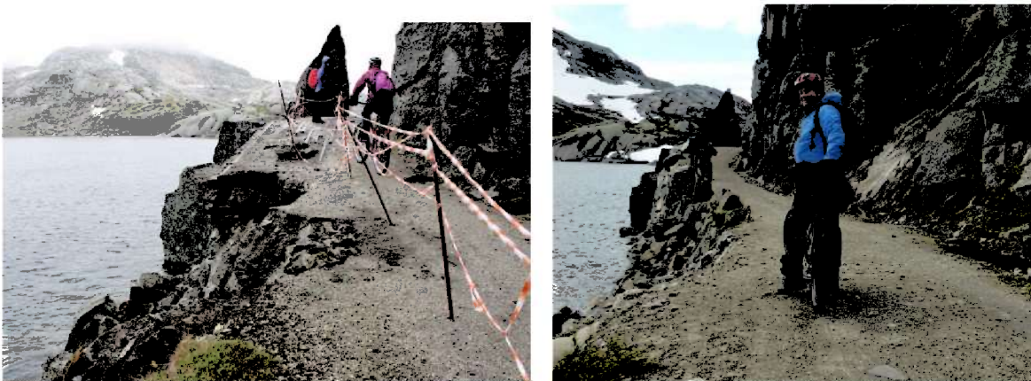
Tv: Mur ved Høgda som glei ut i vårløysinga 2013. Th: Reparert seinhaustes same år.
