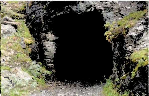
Th: Tunnelen under banen ved Kleven bru
