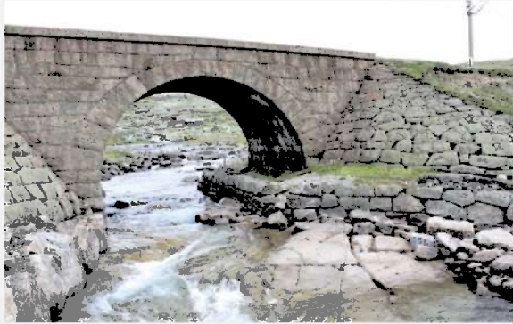
Element nr. 1 Bru over Finseåa
