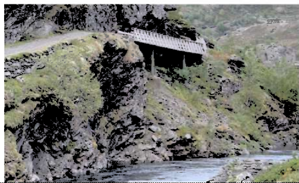
Th: Bru til erstatning av utrasa mur.
