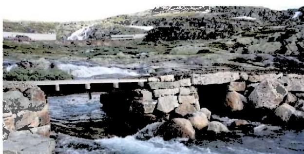
Tv: Mørkaskjeringa – vegen er tidlegare flytta ut og ned på eit lågare nivå. Th: Ved Hallingskeid – hellebru og trebru på jernbaneskjener.
