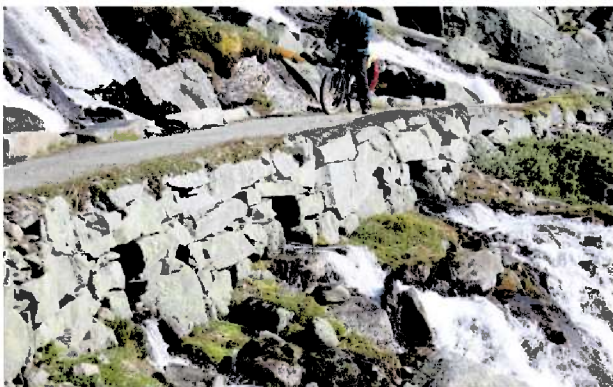
Tv: Opprinneleg stikkrenner i god stand. Th: arbeid med å restaurere grøft og stikkrenne.
