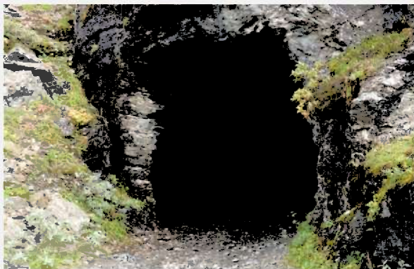
Element nr. 20 Vegtunnel Kleven
