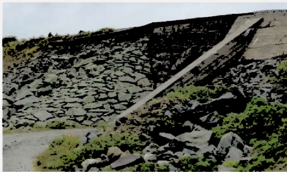
Element nr. 3 Undergang Finsesvingen
