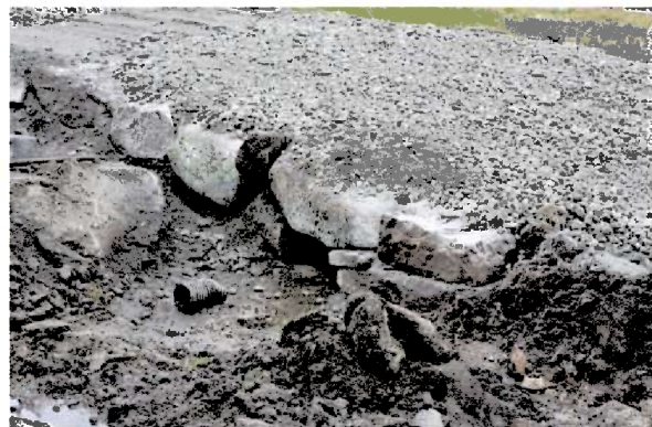
Tv: Opprinneleg stikkrenner i god stand. Th: arbeid med å restaurere grøft og stikkrenne.
