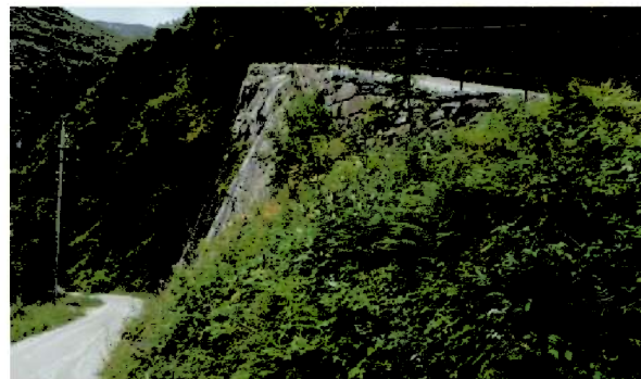
Th: mur med sikring, Myrdalsvingane.
