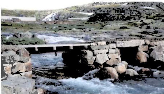
Tv: bru på skjener og hellebru, Hallingskeid.
