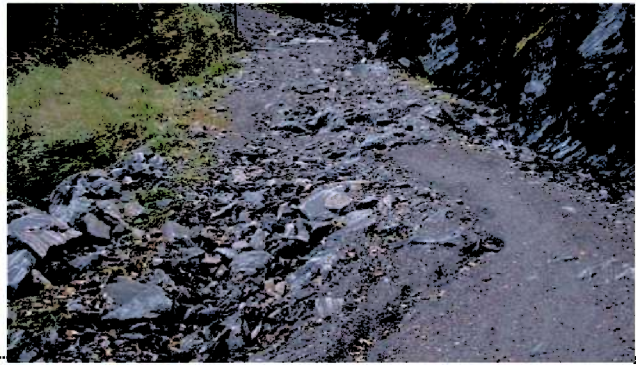
Th: Før rehabilitering.
