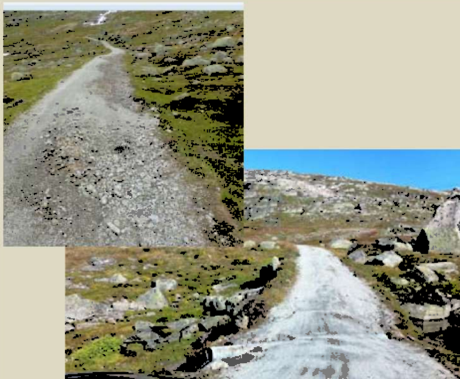
Element nr.4: Frå undergang Norenut - Slirå
