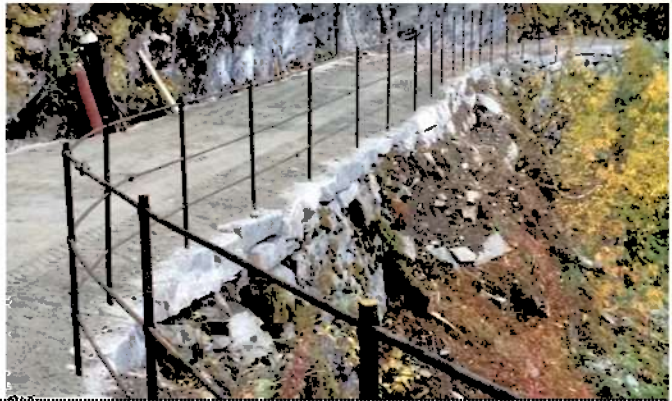
Tv: Nygrusa veg opp mot Leite brakke og Myrdal stasjon. Th: Svingane - mur med sikring.
