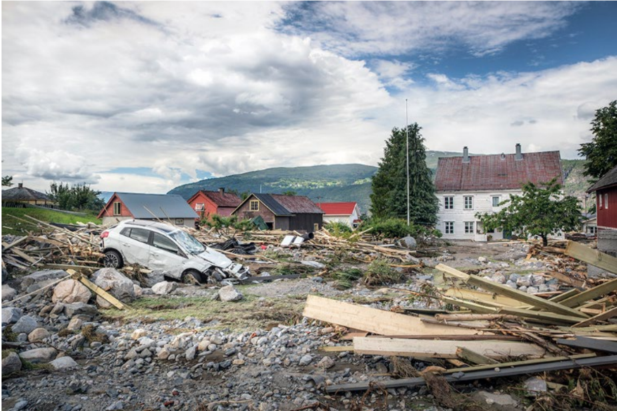
Bilete: Natt til 24. juli 2017 regna det svært mykje, og Utvik i Stryn kommune vart råka av flaum. Uveret gjekk hardt ut over fylkesveg 60, og to bruer vart øydelagde. Foto: Silje Drevdal/Statens vegvesen
