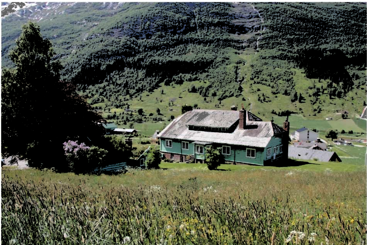
Figur 2. Tunet sett frå nord. Der vi ser baksida av hovudhuset, lengst til venstre er stabburet og framfor det ligg tenarbustaden/drengestova. Kafeen er skjult bak treet til venstre.
