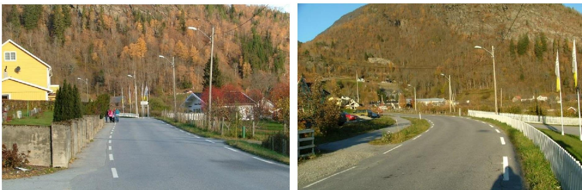
Figur 5: Foto over til venstre viser muren mellom gravplassen og fylkesvegen, det er smalt for gåande mellom kvitestripa og muren. Foto over til høgre viser skulder forbi bustadhus nordaust for gravplass og overgang til gang- og sykkelveg. Foto: Torunn Løne Vinje, Luster kommune.
