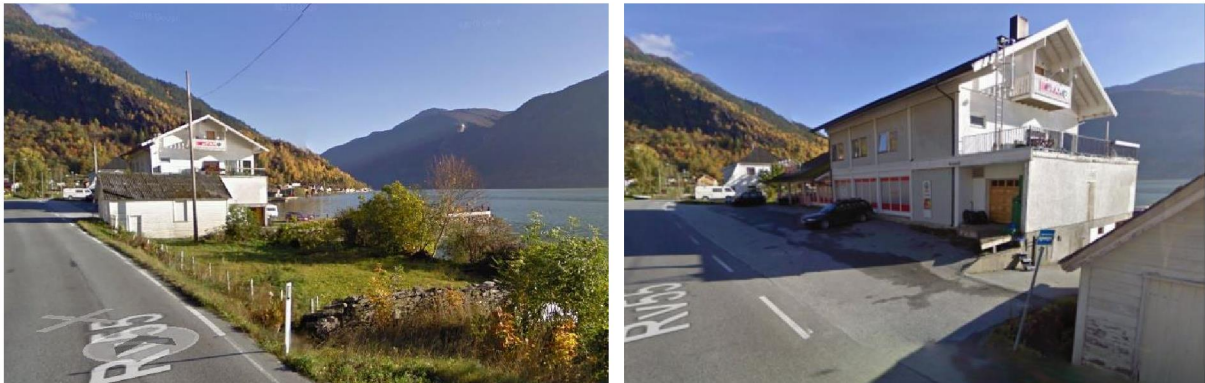
Figur 3: Foto over til venstre viser naust og området regulert til spesialområde nedom vegen for Prestebustaden. Foto over til høgre viser området framfor butikken, veg ned til båthamna ved buss-skiltet. Foto: www.google.com
