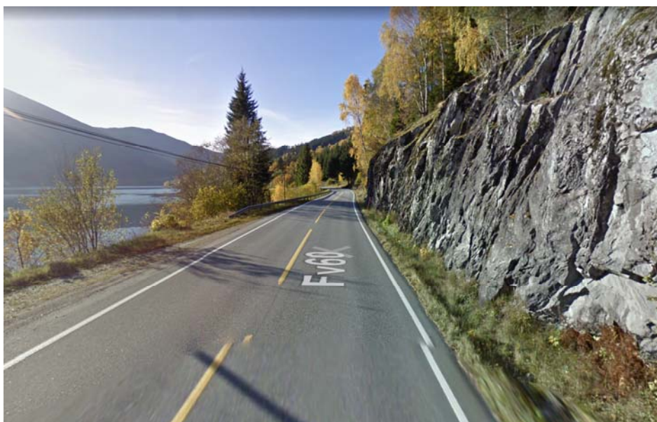
Terrenget på oppsida av fylkesvegen er til dels bratt. Bygging av gang/sykkelveg vil medføre vesentleg masseoverskot på parsellen.
