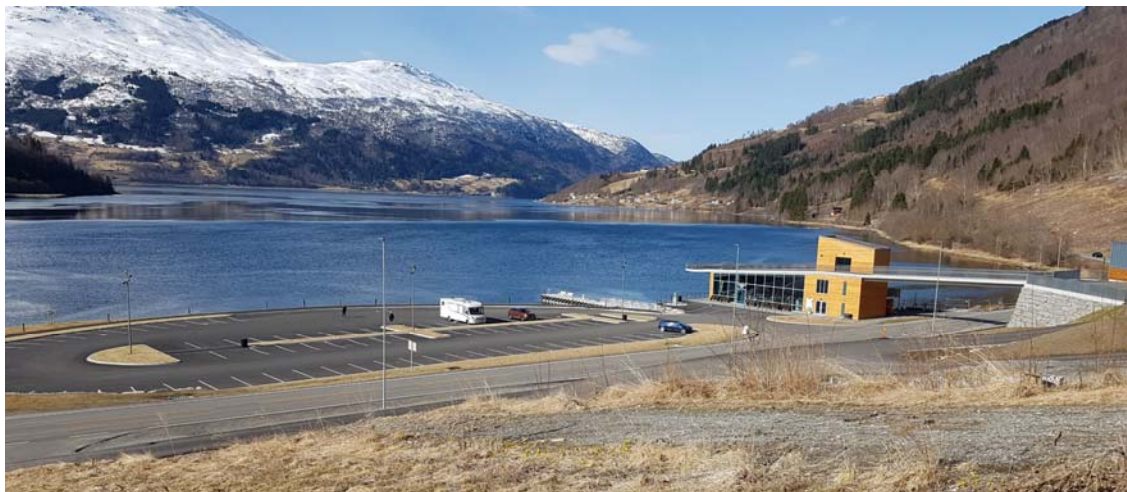
Fjordstasjonen til Loen Skylift med eksisterende parkeringsplass og gangbru over fv.60.
