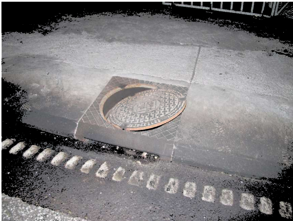
Figur 30: Sandfangkum med sluk om lag 270 meter nedenfor brannstedet. På bildet ses mørke spor av bensin som har rent forbi sluket. Foto: SHT
