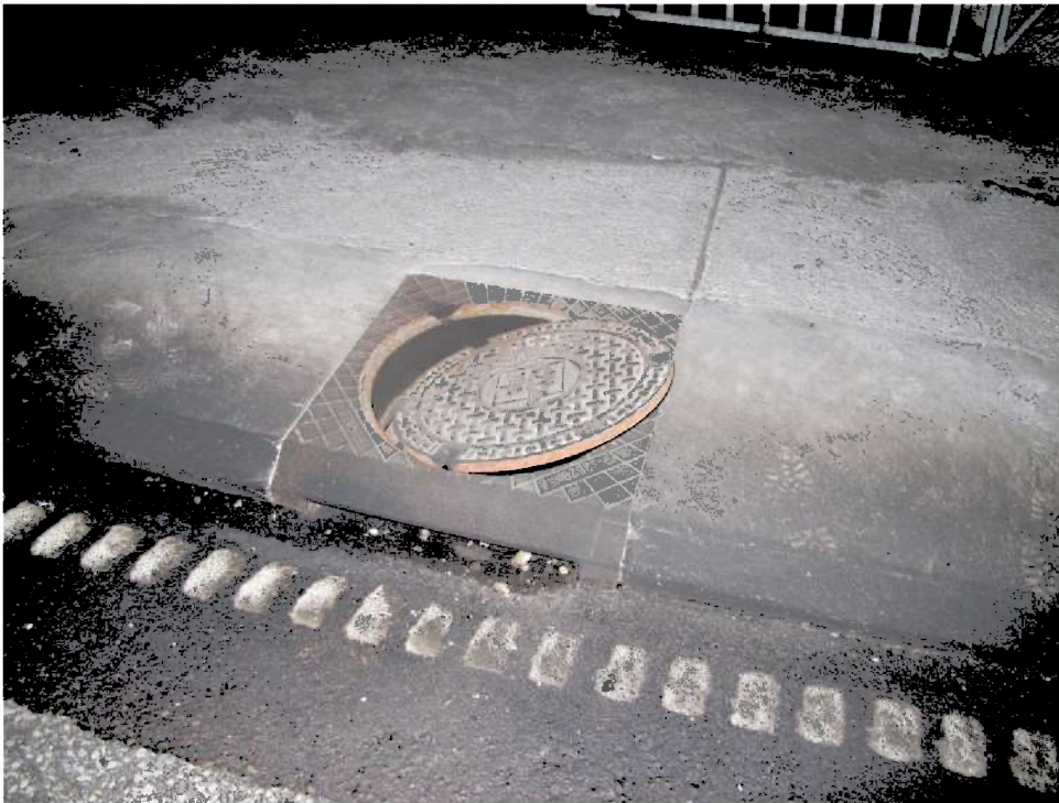
Figur 3 En dräneringsbrunn där bensin kan samlas upp genom den 60 cm breda och ca 5 cm höga öppning ("svalg") som finns mot vägbanan. Den svarta strimma (ungefär 0.7 m bred i bilden) på vägbanan är där den största andelen bensin rann ner och som sedan tog eld (därav märken). Brunnen på bilden stod 187 m nedanför släpet.
