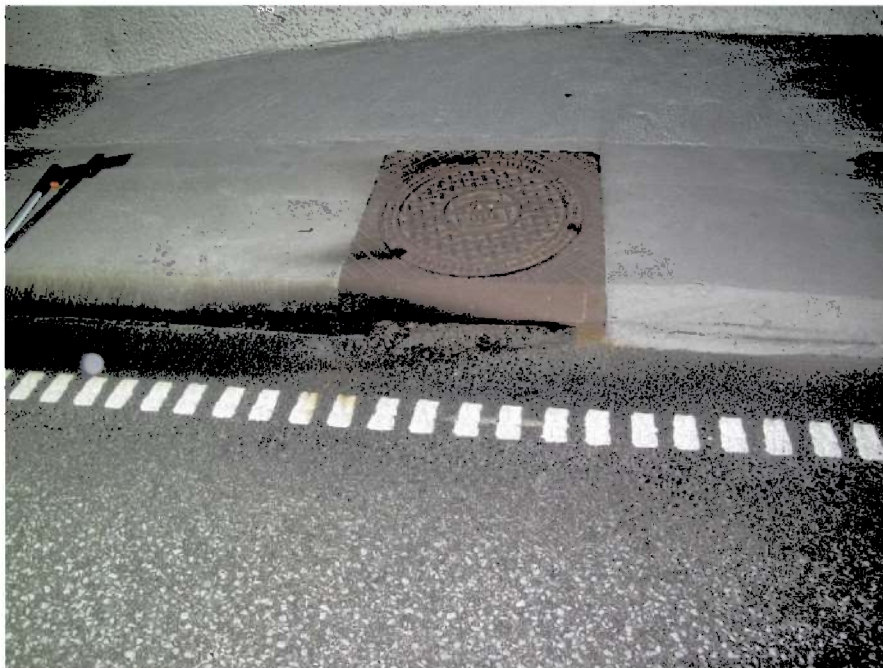
Figur 4 Bilden visar lägst placerade brunnen som är nummer 1 i Figur 3. Där syns tecken på att bensin har runnit ner i brunnen men inte förbi. Denna bensin beräknas ha nått ner till brunnen ungefär 25 sekunder efter brandstart (3 minuter efter olyckan) och flamfronten ungefär 2 minuter efter brandstart.
