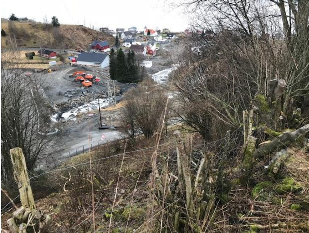
Den bratte brekka ned mot Hage og ned mot elva. Den gamle kraftstasjonen stikk ut bak den lille granloppen ved gravemaskinene. NVE har laga nytt elveløp derifrå og nedover mot fjorden.
