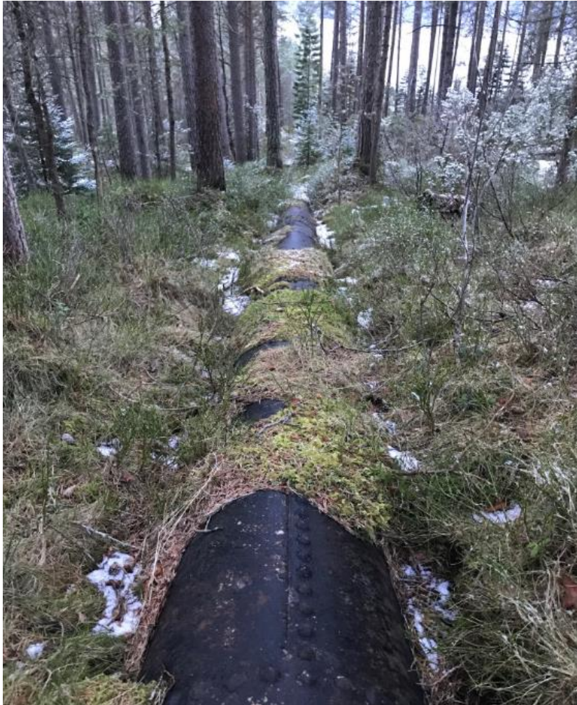
Den gamle rørgata i skogteigen nedanfor dammen. Det nye røret vil ligge i same traseen etter at gamlerøret er fjerna.
