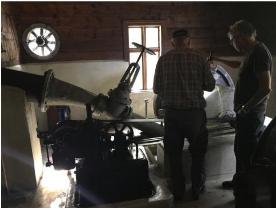
Interiør frå det gamle kraftverket Utvik I som vart sett i drift i 1914 – med maskineri frå 1929.
