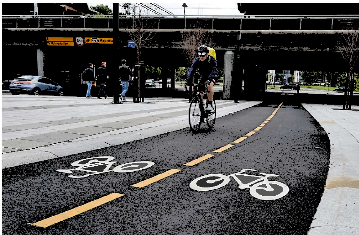
Foto: Knut Opeide/Statens vegvesen
