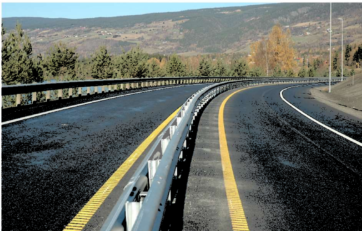
Foto: Steinar Svensbakken/Statens vegvesen
